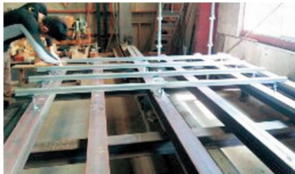
鋼製根太施工
